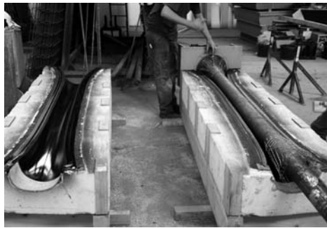
(d) Composite column prior closing of formwork
